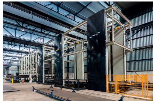
Automatic Storage Almacén automático
